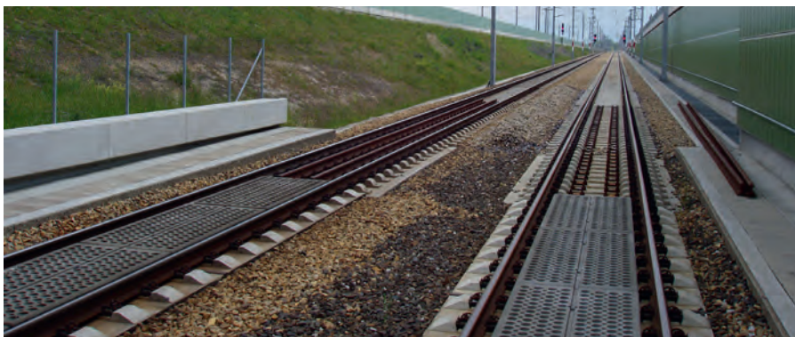
Verklebung von Schotter im Bereich von Übergängen.
