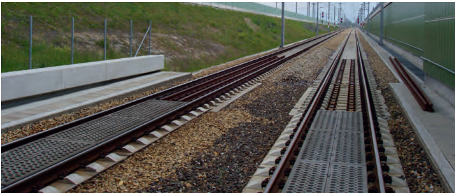
Collage du ballast au niveau des transitions
