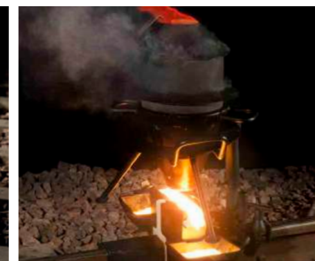
Schweißen mit dem Euro-Tiegel Welding with the Single Use Crucible Soudage avec le Creuset jetable
