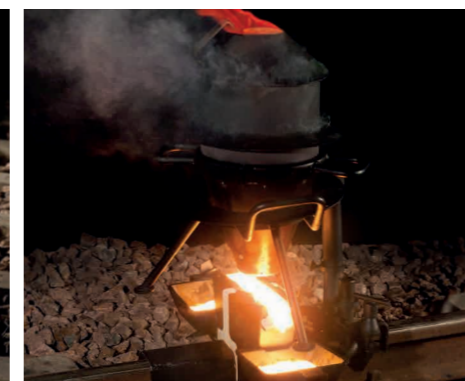
Schweißen mit dem Euro-Tiegel Spawanie za pomocą tygla Euro Sudură efectuată cu Euro-creuzet
