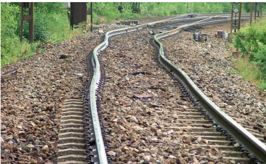
Binario con rotaie svergolate Vía con pandeo del carril
