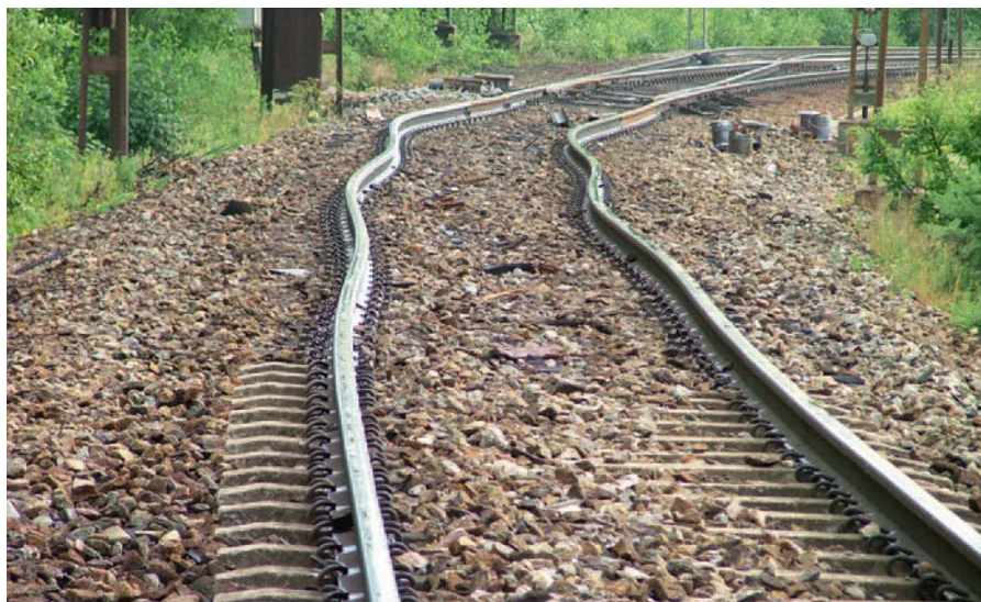
ゆがみが生じたレール Rails with buckles
