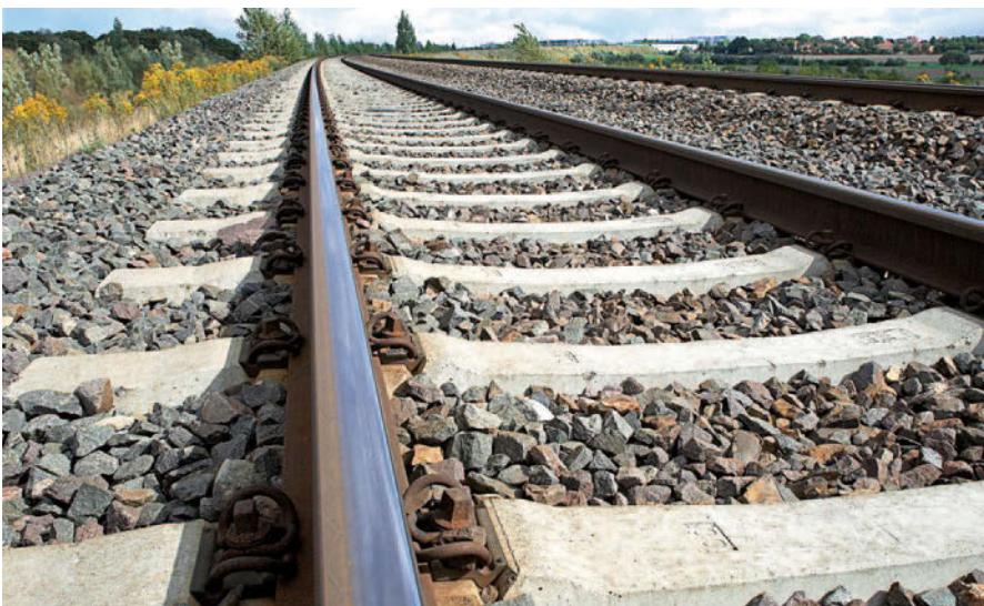
ゆがみがないレール Rails without buckles
