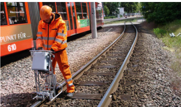
ストレスフリー温度の測定 Inspection of the stress-free temperature
