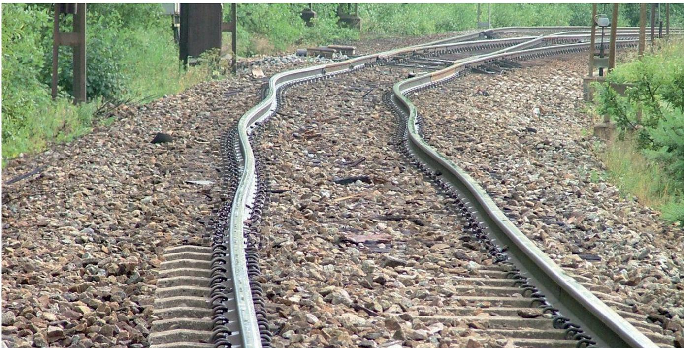
Abb. 1: Typisches Bild einer Verwerfung aufgrund zu hoher, wirksamer Drucklängsspannungen im Schienengleis
