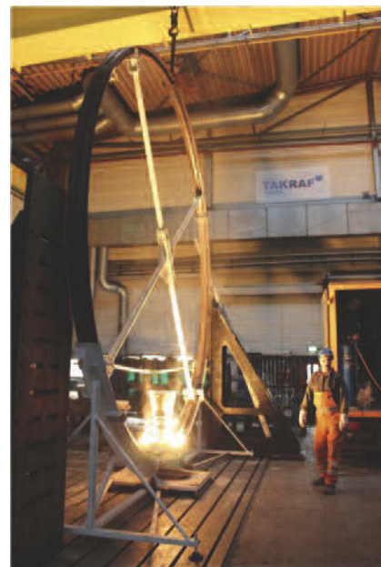
▲ Bild 4. Einlaufen des „Thermit“ bei der Ringschweißung
