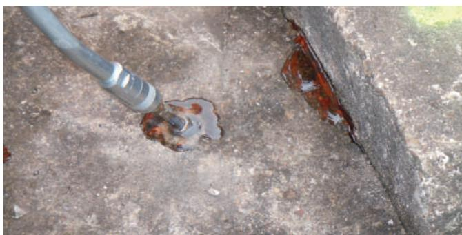
*In das hergestellte Bohrloch wird das Injektionsharz GREBOPOX® SVH injiziert und somit die Schwelle wieder stabilisiert.*
