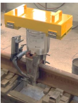
Afbeelding 3: plaatsen van het Envirofilter™ parallel aan de rail
