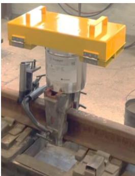
Figure 3 : positionnement de l'Envirofilter™ parallèlement au rail
