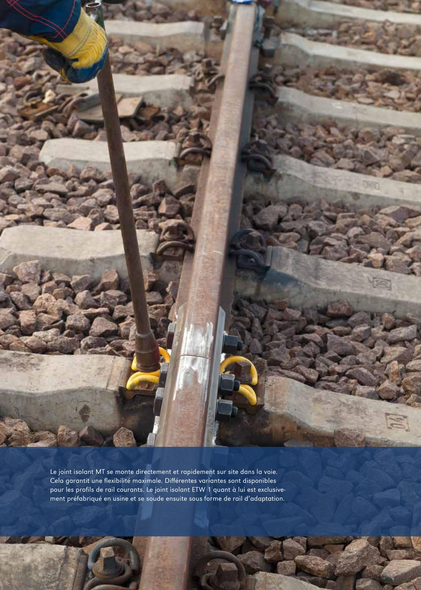
Le joint isolant MT se monte directement et rapidement sur site dans la voie. Cela garantit une flexibilité maximale. Différentes variantes sont disponibles pour les profils de rail courants. Le joint isolant ETW 1 quant à lui est exclusivement préfabriqué en usine et se soude ensuite sous forme de rail d'adaptation.
