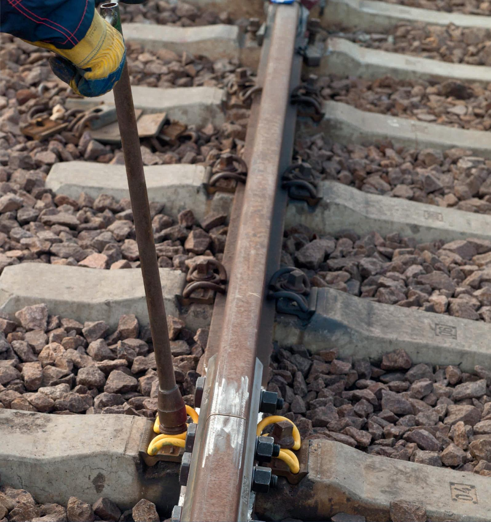
Den Isolierstoß MT können Sie direkt und schnell vor Ort im Gleis montieren. Ein Höchstmaß an Flexibilität ist hierdurch gesichert. Er ist für alle gängigen Schienenprofile verfügbar und in unterschiedlichen Ausführungsvarianten erhältlich. Der ETW 1-Isolierstoß wird dagegen ausschließlich werksseitig gefertigt und anschließend als Passschiene eingeschweißt.
