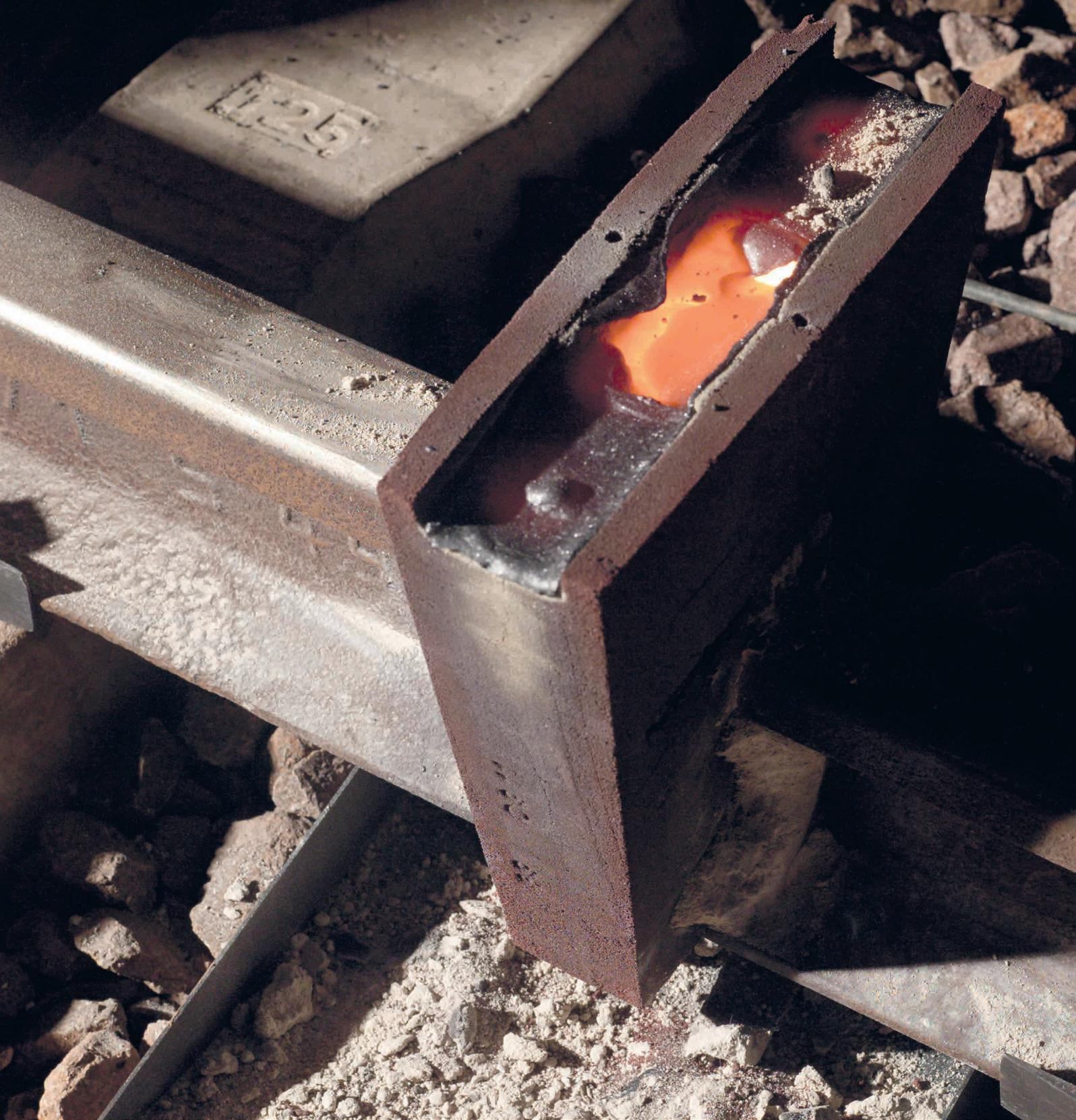
Mit unseren patentierten THERMIT®-Schweißverfahren können alle schienentechnischen Schweißaufgaben gelöst werden: von Vignol- über Rillen- bis zu Kran- und Stromschienen selbst bei unterschiedlichen Profilen oder Schienengüten und das weitgehend unter Aufrechterhaltung des Arbeits- und Fahrbetriebs. Die einzigartigen Vorteile: optimierter Zeit-, Material- und Personalaufwand sowie höchste Qualität, hohe Zuverlässigkeit und Verfügbarkeit des Gleises.
