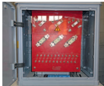
Transformator-Box (für jede Weiche) Power transformer (for each switch)
