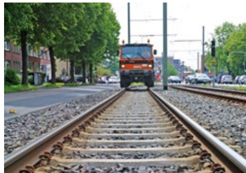
Unités de meulage en fonctionnement. Grinding unit in operation.
