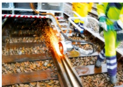
Travaux de meulage sur voie couverte. Grinding work on covered tracks.
