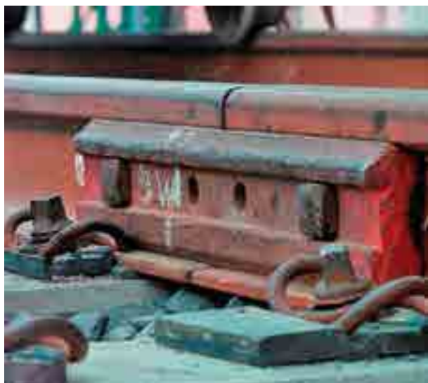
Bild 1: Schienen mit Laschen verbunden
