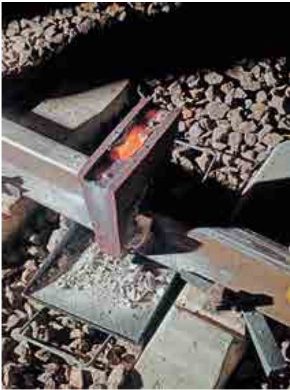
! Bild 4: Mit Schweißgut gefüllte Form
