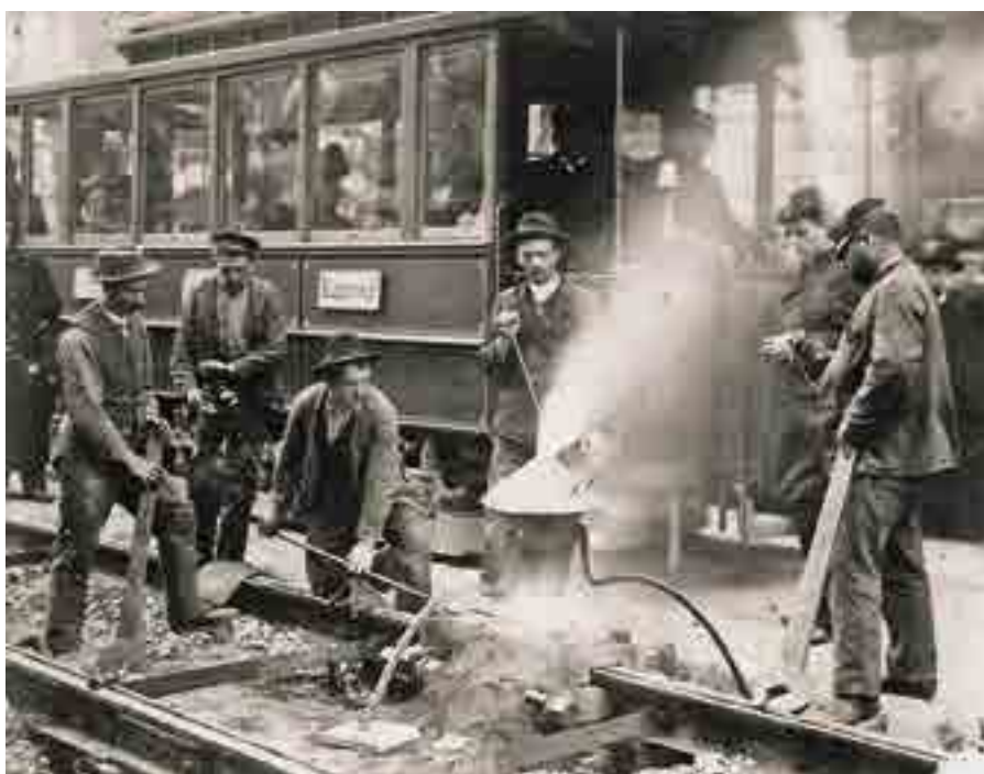
Bild 3: Thermit®-Schweißung vor 1914
