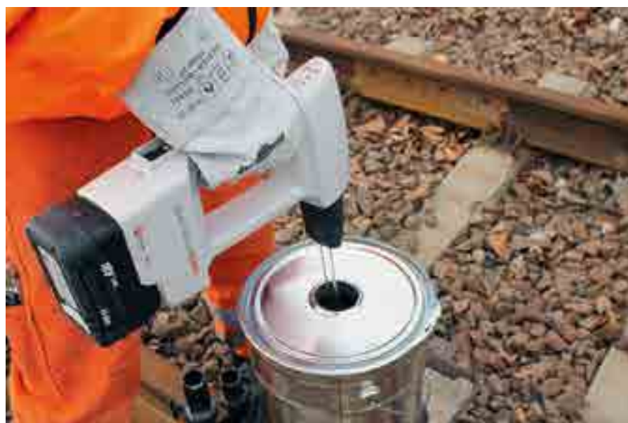
■ Bild 7: Verfahrenssicherheit mit Thermit®-Zündvorrichtung
