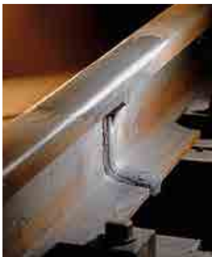
Bild 2: Lückenlos verschweißtes Gleis
