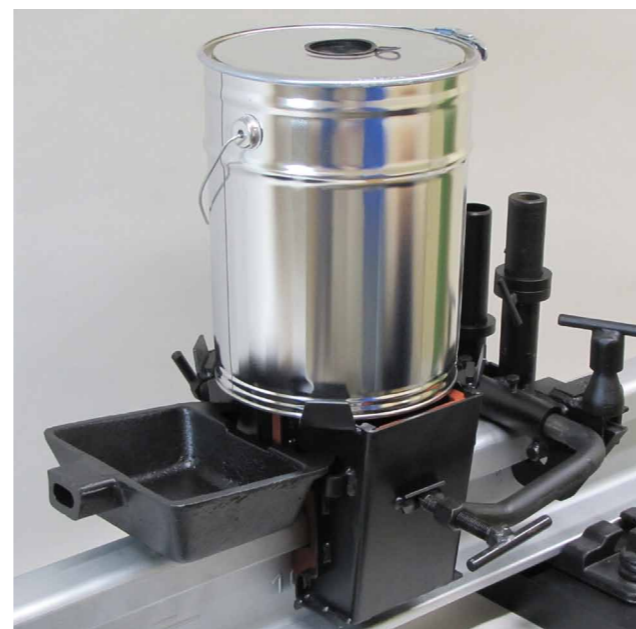
Aufbau einer THR Schweißung Set up of a THR weld Montage d'une soudure THR
